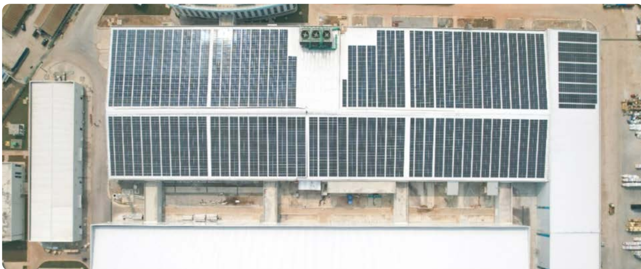
印度尼西亚工厂光伏面板（建造中）
